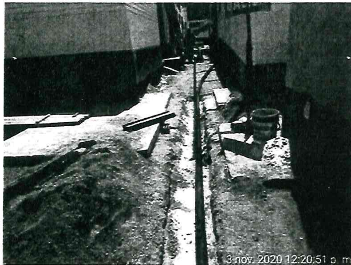
SISTENA ACI: instalación de Tubería HDPE 2 ½"-BLOQUE B3-D
