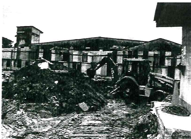
Demolición y Eliminación de Estructura Existente
