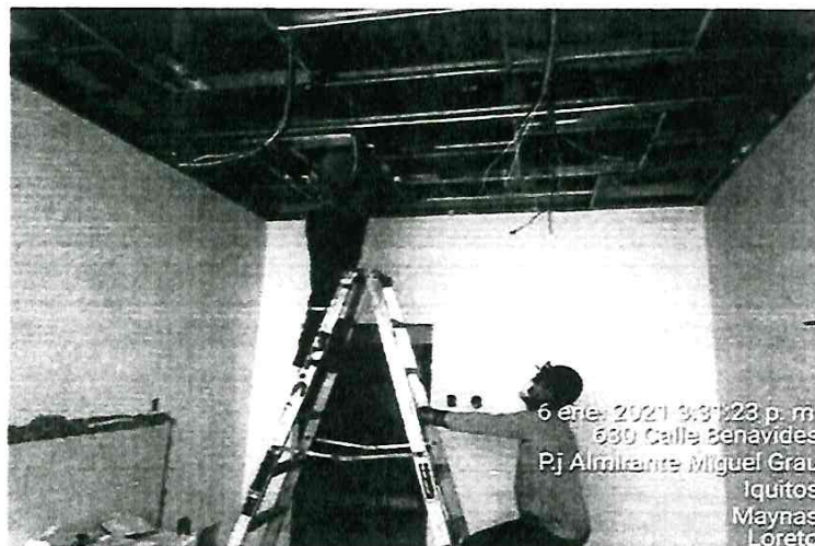
SISTEMA ACI: Instalación de Red de Alimentación de Rociadores de 1"-BLOQUE B-2 PISO
