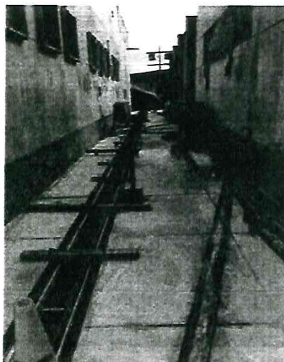
Carpintería Metálica: Marco para Rejillas Pluviales
