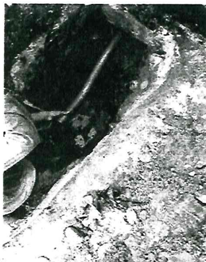
COMUNICACIONES: Excavación y puesta de tubo PVC 2" a buzón exteriores entre el bloque D y E
