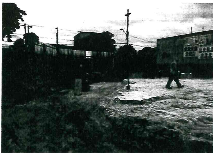
Relleno compactado C/ Equipo, con material Propio.
